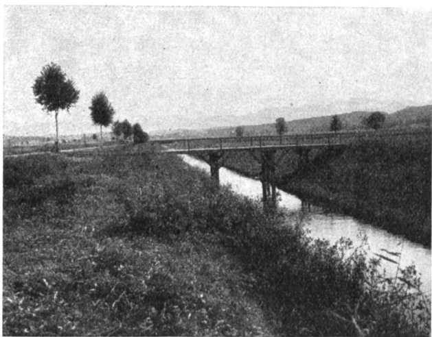
Abb. 4 Der schnurgerade Kanal durch das anbaugeschlachtete Gossauer Ried. Die wenigen stehen gebliebenen Bäume können keinesfalls als Windschutz gelten. Glücklicherweise ist eine neue Bepflanzung der Wasserläufe vorgesehen.
