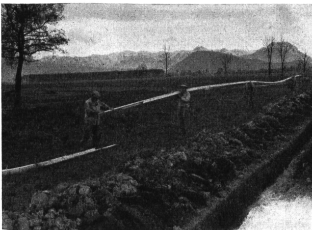
Abb. 6 Melioration der Rheinebene. Holzkastendrain.
