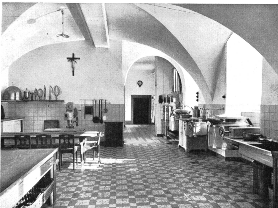
Fig. 29 Klosterküche Engelberg. Kippkessel, Autoklav und Kaffeemaschine.
