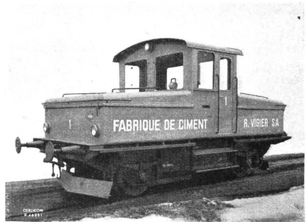
Abb. 2 Moderne Werklokomotive 100 PS, Aktionsradius 6400 tkm, Gewicht 25,5 t.
