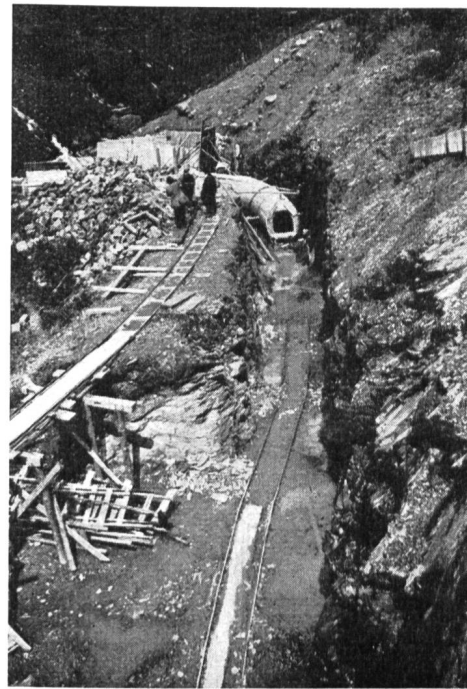
Abb. 5 Kraftwerk Tagenstal, Zuleitungsstollen im Bau.
