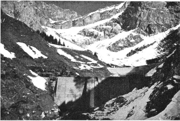
Abb. 6 Kraftwerk Tagenstal, Staumauer für den provisorischen Weiher
