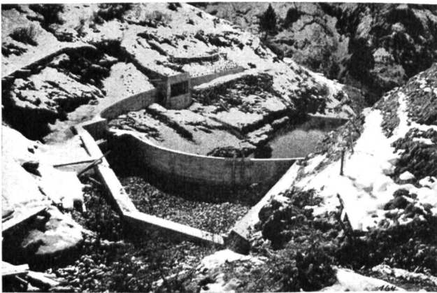
Abb. 4 Kraftwerk Tagenstal, Gesamtansicht der Fassungsanlage mit Ueberlauf, Blick in den provisorischen Weiher.
