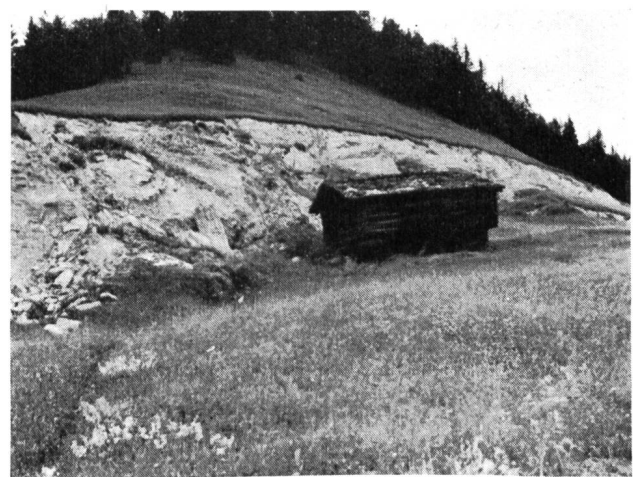
Abb. 5 Rutschung bei Schuders. Aufnahme vom 12. Juli 1941. (Nr. 7828 BRB 3.10.39)
