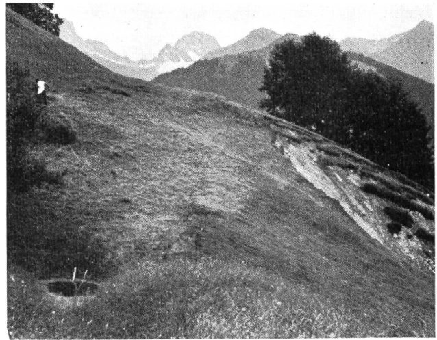
Abb. 4 Rutschung bei Schuders. Aufnahme vom 12. Juli 1941. (Nr. 7828 BRB 3.10.41)
