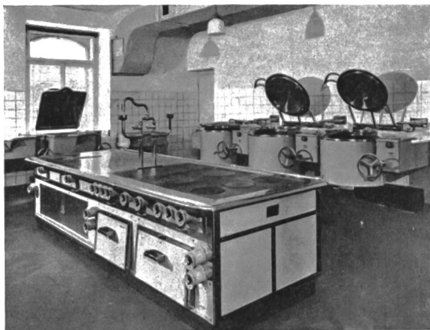
Fig. 63 Teilansicht der elektrischen Küchenanlage des Sanatoriums «Du Midi», Davos, S. B. V. K.
