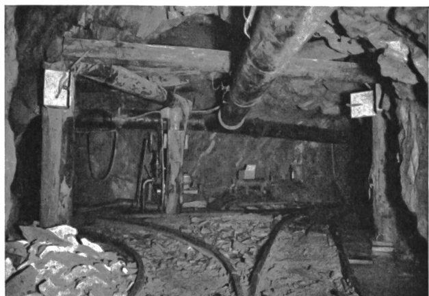
Abb. 5 Kraftwerk Gampel III. Kreuzung eines Fensters mit dem Stollen.
