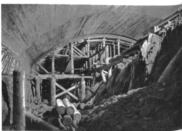
Abb. 9 Kraftwerk Innertkirchen. Ausbruch der Kalotte für die Zentrale mit Gewölbebetonierung.
