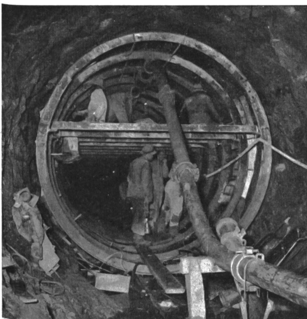
Abb. 3 Kraftwerk Innertkirchen. Betonierung des Zulaufstollens.
