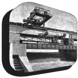
Einlaufrechen und Rechenreinigungsmaschinen Dammbalken- und Maschinenhaus-Krane Verladeanlagen
