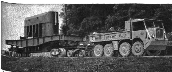
Transport eines Transformators von über 70 Tonnen Gewicht
