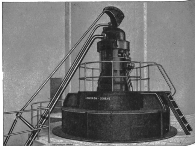
Halbautomatisches Kraftwerk der Randsfjord Traemasse og Papirfabrik, Norwegen, mit Dreiphasen-Generator für Antrieb durch eine Kaplan-turbine von 1900 PS bei 167 U/min.
