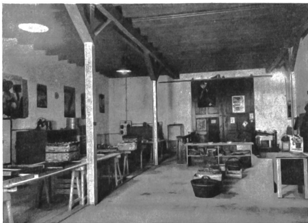
Fig. 3 Gemeindedörranlage Küsnacht. Blick in den Dörrraum. Installation de séchage de la commune de Küsnacht. Vue dans la chambre de séchage.
