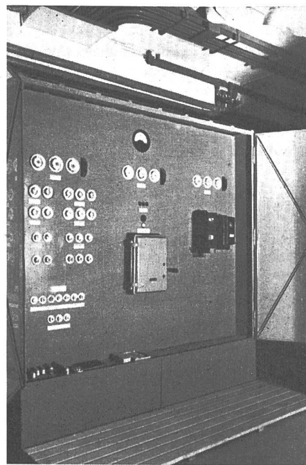
Fig. 42 Hauptverteiltableau, offen.
