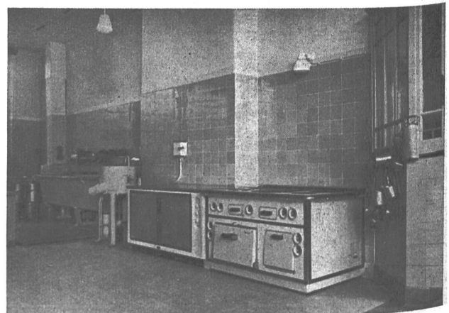
Fig. 49 Angestelltenküche mit Wärmeschrank und Herd. La cuisine des employés avec armoire chauffante et cuisinière.
