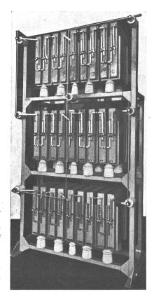
Fig. 11 Hochsparnungs-Nepolin-Kondensatorenbatterie
