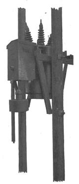
Fig. 18 Oelschalter mit selbsttätiger Wiedereinschaltvorrichtung (Sprecher & Schuh A.-G., Aurau)
