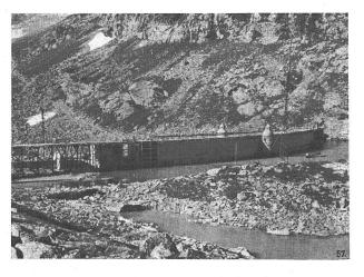
Abb. 4 Scalamauer, Baustadium Ende August 1941. — Von rechts Ueberfallwerk, Oeffnung für automatische Klappe und Notschütze. Der Turm wasserseitig wird abgebrochen-
