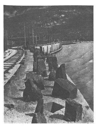
Abb. 10 Lago-Bianco-Mauer; Ausbau 1941 fertig; Anschluss für definitive Erhöhung; vorn Dilatationsfuge.
