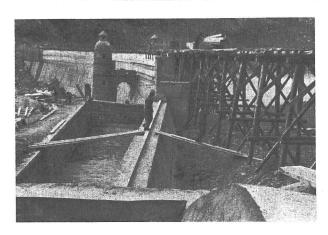
Abb. 8 Staumauer Scala, Ueberfall prov. Kote 2237,16, Ende August 1941; in der Fortsetzung autom. Klappe.
