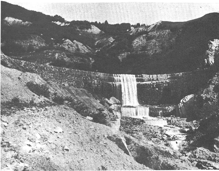
Abb. 1 Nollaverbauung. Sperre I, Zustand um 1900. (Nr. 5045 BRB 3. X. 1939)
