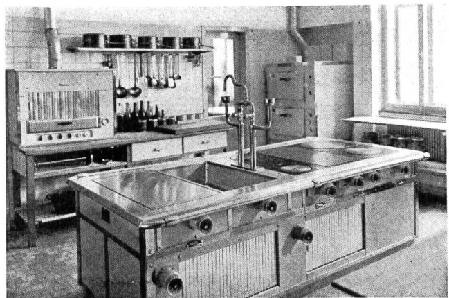
Fig. 4 Die neue elektrische Grossküche. La nouvelle grande cuisine complètement électrifiée.
