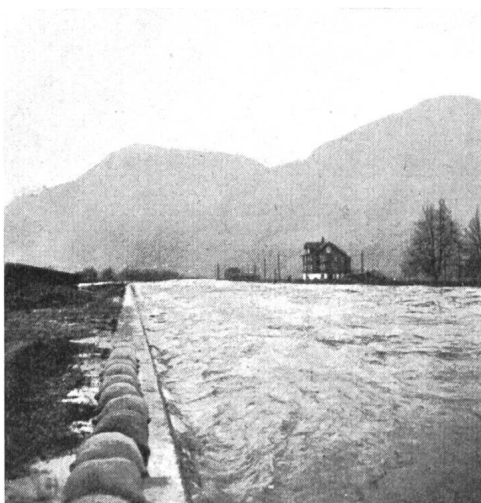
Abb. 12 Unteribach. Linkes Ufer (km 1,75). Sandsacksicherung, neues Leitwerk überspült.
