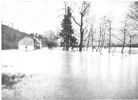
Abb. 14 Beim Langsteg (km 3,53). Blick aufwärts.
