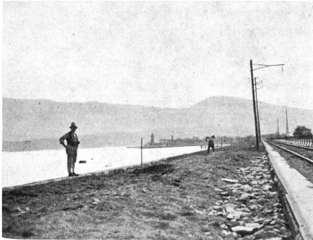
Abb. 5 Dammbreiterung. Blick gegen Hurden.
