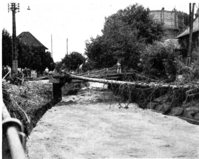
Abb. 3 Felsenge der Jona beim Gaswerk Rüti nach dem Hochwasser, flussabwärts gesehen.
