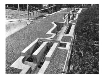
Abb. 2 Ansicht von Zulausgerinne mit Rechen, Entlastung und Sandsang, in Fliessrichtung gesehen.
