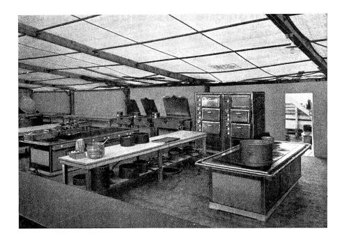
Fig. 3 Teilansicht der vollelektrischen Grossküche am Eidg. Schützenfest 1939 in Luzern. Vue partielle de la grande cuisine complètement électrifiée du Tir Fédéral 1939 à Lucerne,
