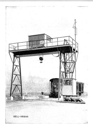
Abb. 4 Feststehender Bockkran mit Rangierspill.
