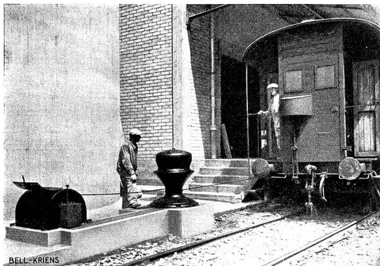
Abb. 1 Rangierspill für 1500 kg Zugkraft, kombiniert mit unversteckter automatischer Seilbaspel und Betätigung durch Pedal (Siehe Artikel Seite 125).
