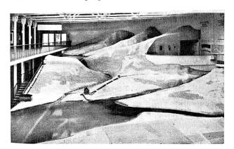
Abb. 2 Das Wasserbaumodell. Hochdruck- und Mitteldruckanlage. Versuchsanstalt für Wasserbau an der E.T.H.
