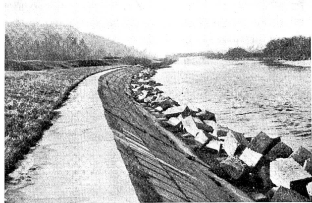
Abb. 19 Thur bei Amlikon 1931. Betonplatten und Betonblockvorgrund. Eidg. Oberbauinspektorat.
