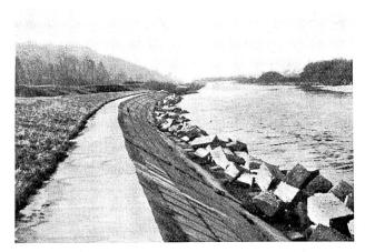
Abb. 19 Thur bei Amlikon 1931. Betonplatten und Betonblockvorgrund. Eidg. Oberbauinstektorat.
