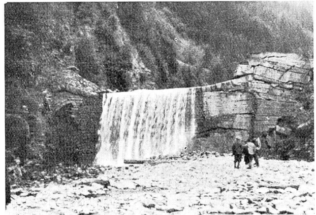
Abb. 16 Sperre III an der Nolla aus dem Jahre 1903. Zustand 1937. Fortschreitende Zerstörung durch seitlichen Bergdruck vom linken Ufer her. Eidg. Oberbauinspektorat.
