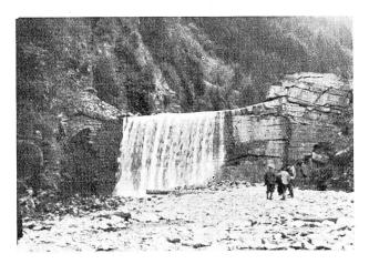
Abb. 16 Sperre III an der Nolla aus dem Jahre 1903. Zustand 1937. Fortschreitende Zerstörung durch seitlichen Bergdruck vom linken Ufer her. Eidg. Oberbauinspektorat.
