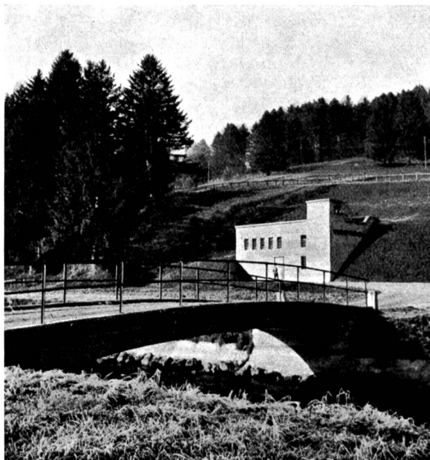
Fig. 1 Station de pompage à Cortébert.
