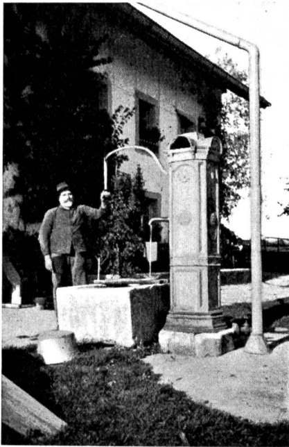
Fig. 6 Conduite d'adduction de l'eau du toit à La Chaux d'Abel.
