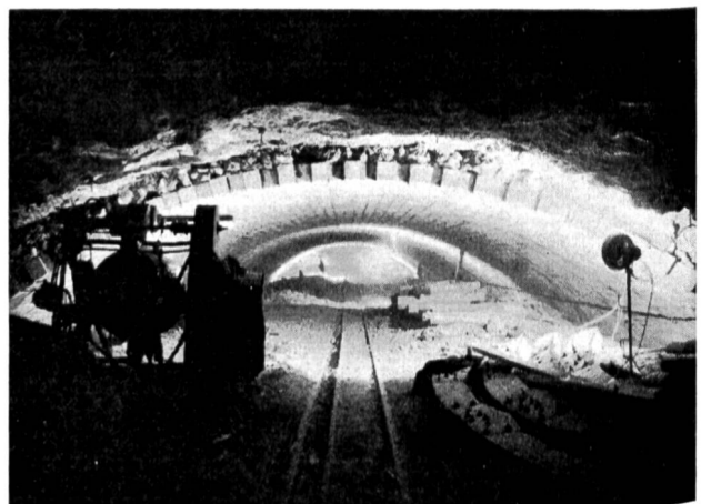
Fig. 6 Tunnel de dérivation R. G. Construction de la voûte en parpaings.
