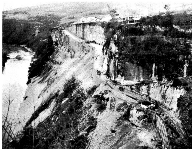
Fig. 7 Route d'accès à l'usine.
