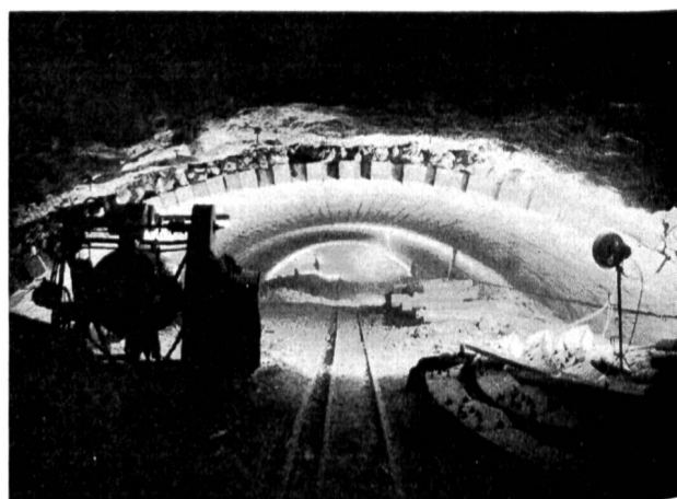
Fig. 6 Tunnel de dérivation R. G. Construction de la voûte en parpaings.
