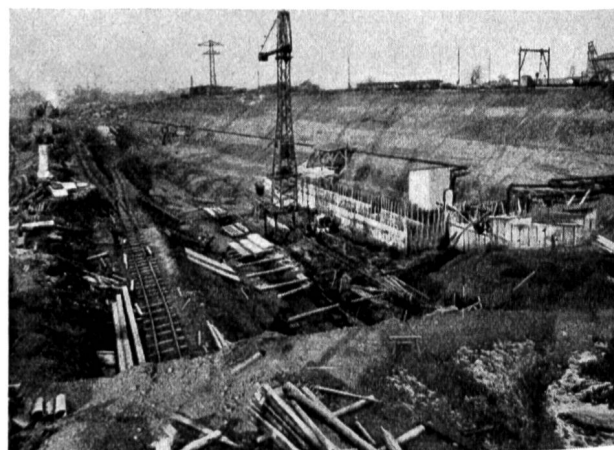
Abb. 6 Kraftwerk Reckingen Baugrube für das Krafthaus, Wasserhaltung 5 m unter Rheinspiegel.
