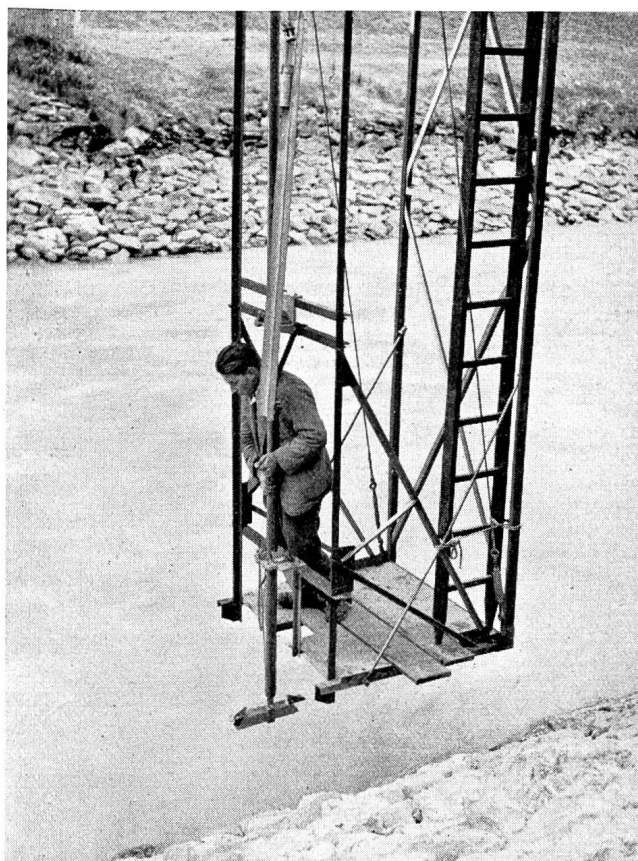
Abb. 117 Klappenschöpfgefäss vom Wassermesswagen aus benützt.
