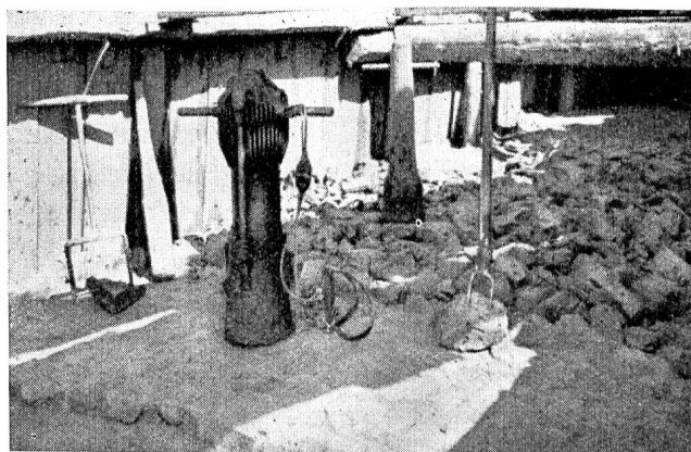
Abb. 83 Hühnermattdamm. Lehmern im Schlitz.
