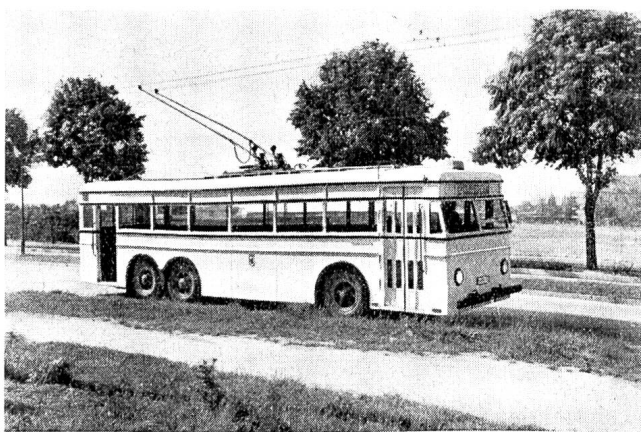
Abb. 16 Trolleybus der Berliner Verkehrsgesellschaft für 153 PS, 65 Fahrgäste.
