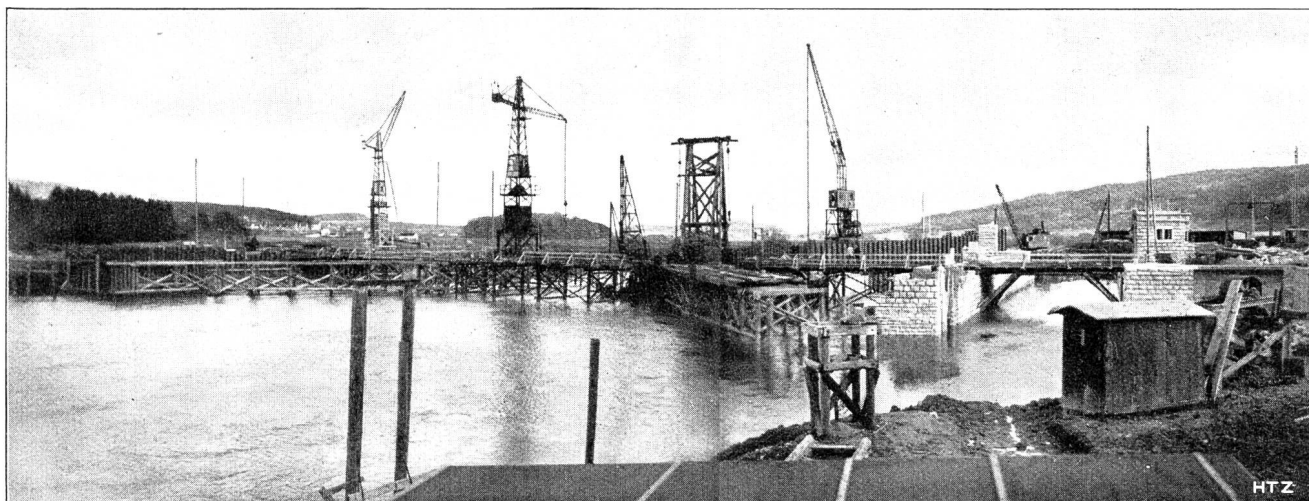
Abb. 37 Stauwehr Nidau Dienstbrücke und Schiffschleuse vom Oberwasser gesehen.
