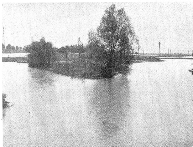
Abb. 10 Hochwasser vom 28. September 1936. Blick auf die alte Linth oberhalb der Grynau-Brücke.
