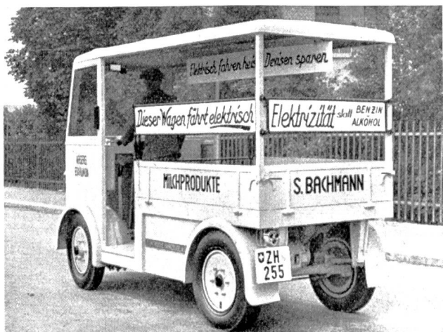
Fig. 47 Dieses Fahrzeug, ein Milchwagen in Eschlikon, Kt. Thurgau, mit einer Nutzlast von 1000 kg besitzt eine Geschwindigkeit von 20 km/h und einen Aktionsradius von 50—60 km pro Batterieladung. Der Wagen ist ausgerüstet mit einer Panzerplatten-Batterie, für die eine Garantie von 3 Jahren eingeräumt wird, in dem Sinne, dass die Kapazität nach Ablauf dieser Zeit noch mindestens 80% beträgt. Durch die Pneuberufung erhält der Wagen eine tadellose Abfederung, was auf die Lebensdauer der Batterie sich sehr günstig auswirkt. Der Erfolg, der am Tage der Stilllegung der übrigen Kraftfahrzeuge erzielt wurde, darf als ganzer gebucht werden, denn überall wurde dem Fahrzeug die grösste Aufmerksamkeit geschenkt. Die Lieferfirma, Elektrische Fahrzeuge A.-G., Zürich-Oerlikon, konnte inzwischen verschiedene Anfragen entgegennehmen, die auf diesen Propaganda-Feldzug zurückzuführen sind.
