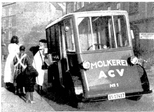
Fig. 6 Elektro-Milchwagen mit geschlossenem Aufbau. Véhicule électrique de laiterie, type fermé.
