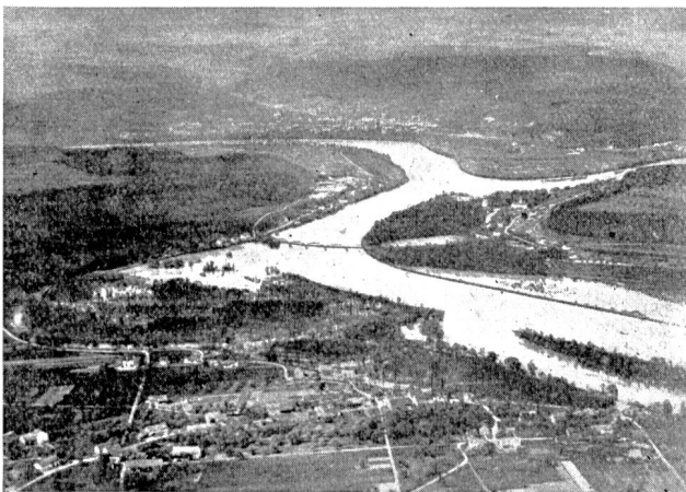
Abb. 26 Kraftwerk Klingnau Flugzeug-Aufnahme des überschwemmten Baustellen-Gebietes vor Beginn der Bauarbeiten. Mündung der Aare in den Rhein mit Waldshut im Hintergrund.
