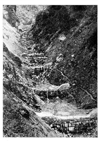
Abb. 47 Guppenruns bei Schwanden. Sperrenbauten in der Sienenschlucht.
