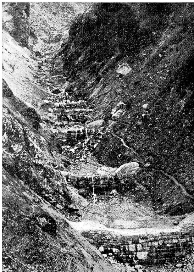
Abb. 47 Guppenruns bei Schwanden. Sperrenbauten in der Siensenschlucht.
