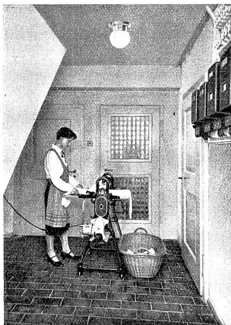
Abb. 5 Keller gang: Die elektrische Wäschemange befindet sich im Keller gang und wird dort vom Haushaltsmotor angetrieben; rechts das Zähler-Tableau.
