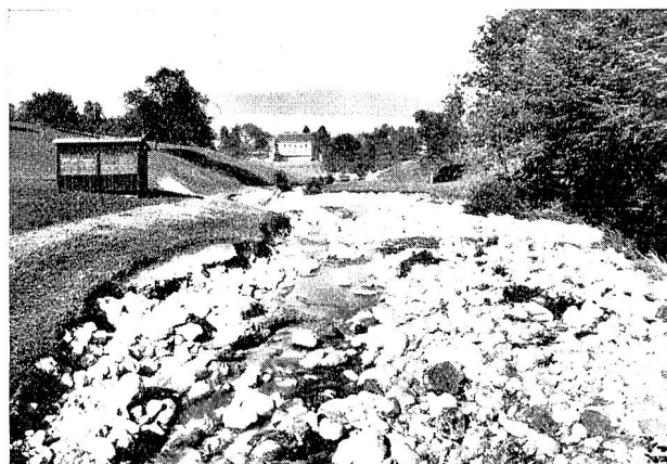
Abb. 8 Der Mühlebach bei Richterswil. Ausweitung des Bettes oberhalb der Ortschaft Elargissement du lit d'un ruisseau en amont de Richterswil
