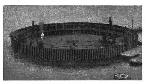
und Schlußbohlen durchgeführt. Das Bild läßt die hervorragende Stellung und vollkommene Wasserdichtigkeit der Spundwand erkennen.
