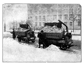
Abb. 22 Elektrokarren von  $1^{1/2}$   $m^3$  Fassungsvermögen beim Abtransport von Schnee.
