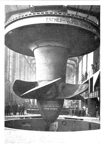
Abb. 15. Kraftwerk Albbruck-Eogern. Turbinenlaufrad mit Abdichtungsdeckel zwischen Turbine und Generator; bereit zum Versenken.
