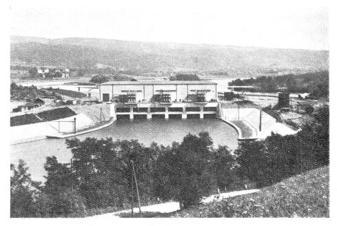
Abb. 12. **Kraftwerk Albbruck-Dogern.** Maschinenhaus vom Unterwasser aus. Der Unterwasserkanal ist gegen den Rhein hin vollständig durchgestochen. Bei jeder Maschine steht an der Außenwand des Maschinenhauses die zudienende Schaltanlage. Ganz im Vordergrund die Landstraße Etzgen-Schwaderloch.
