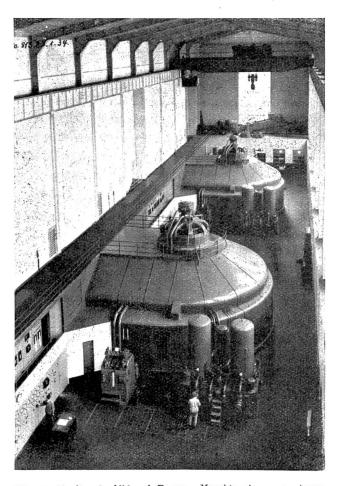
Abb. 14. Kraftwerk Albbruck-Dogern. Maschinenhaus von innen, von der Kranbahn aus aufgenommen. 3 Aggregate von je 300 m³/sek. Wasser bei einem Gefälle von maximal 11,70 m, ergebend eine Maximalleistung von 67,000 kW an den Generatorenklemmen. Das dritte Aggregat, das gegen den Beschauer zu liegt, ist hier nicht sichtbar.
