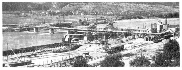
Abb. 4. Kraftwerk Albruck-Dogern. Wehrbaustelle; Blick von unten, Schweizerseite, aus. Auf der rechten Rheinhälfte (auf dem Bilde links) sind erst die beiden Hilfsbrücken für den Bau ersichtlich. Rechts im Bilde die trocken gelegte Baugrube für die Wehröffnungen V und IV.
