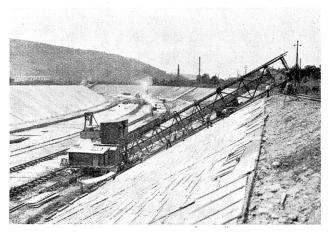
Abb. 8. Kraftwerk Albbruck-Dogern, Oberwasserkanal. Aufbringen der Sohlen- und Böschungs-Pflästerung.
