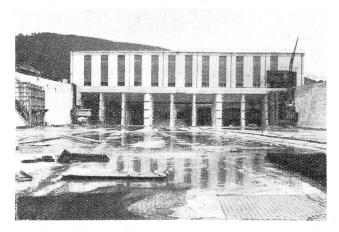
Abb. 11. Kraftwerk Albbruck-Dogern. Maschinenhaus, gesehen von der Oberwasserseite her. Zwecks guter Wasserführung sind die Einläufe jeder der 3 Turbinen durch vertikale Zwischenwände in je 3 Teile geteilt. Bei der mittleren Turbine ist der Konus für die Zuleitung des Wassers zum Laufrad sichtbar. Die Oeffnung rechts ist durch Schützentafeln abgeschlossen.
