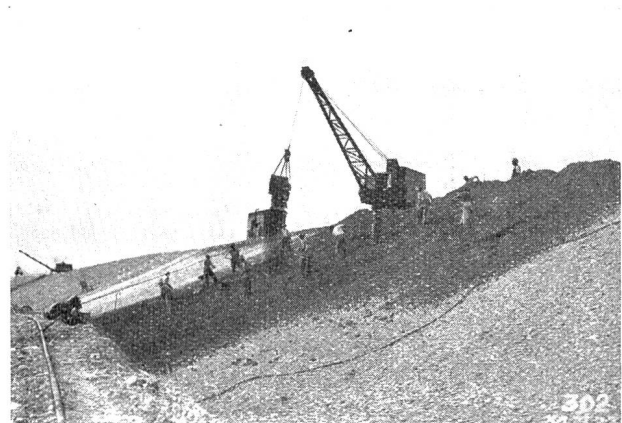
Abb. 6. Kraftwerk Klingnau. Linksseitiger Stausedamm unterhalb Gippingen, Wasserseite. Einbringen und Verteilen des Leimes für die Dammabdichtung mittelst Greifer und Handarbeit auf der Böschung als Vorbereitung für die Walzung.
