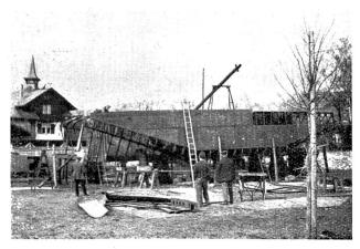
Abb. 4. Zürichsee-Fähre Meilen-Horgen. Mittelschiff beplattet.
