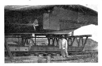
Abb. 6. Zürichsee-Fähre Meilen-Horgen. Steuerruder mit Schraube.
