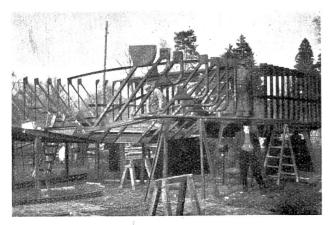
Abb. 3. Zürichsee-Fähre Meilen-Horgen. Schiff in Spanten.
