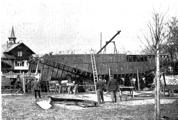
Abb. 4. Zürichsee-Fähre Meilen-Horgen. Mittelschiff beplattet.
