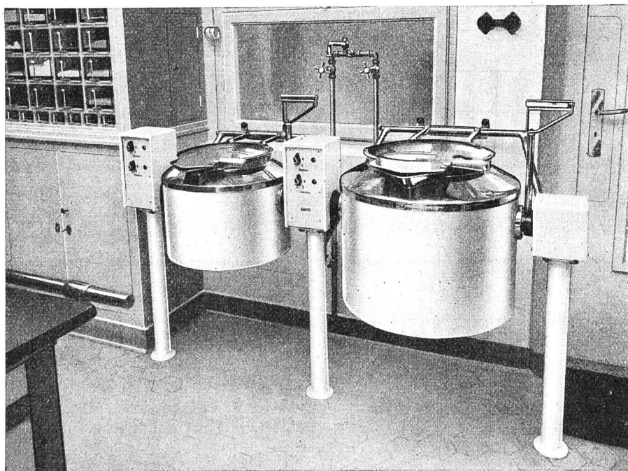
Abb. 86 Elektrische Grossküche im Hotel Vogt in Basel. Ansicht der Kippkesselgruppe.
