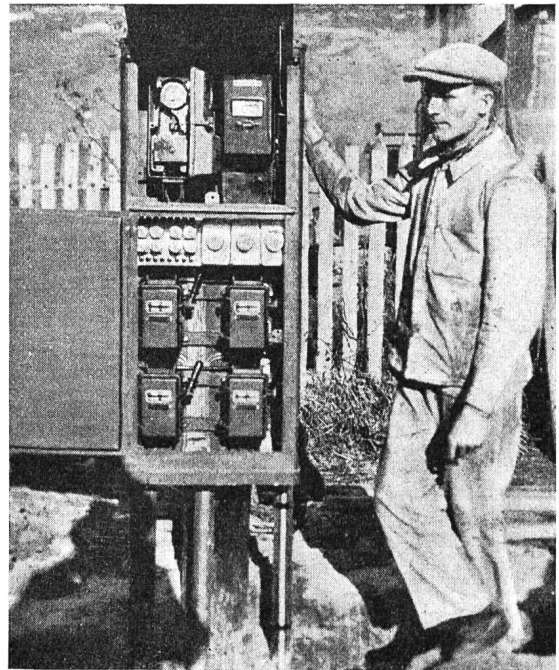
Abb. 17 Schalteinrichtung zur Treibbeetheizung in Visp.
