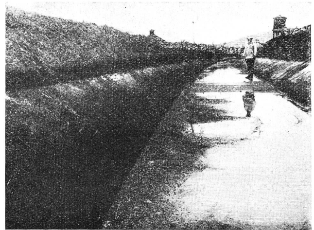
Abb. 7. Ein Teilstück des Kanals in Abb. 6 nach 3/4 jähriger Betriebszeit. Man erkennt, daß an einigen Stellen Pflanzen durch die Decke hindurchgewachsen.
