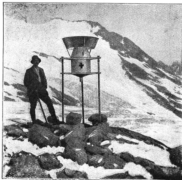
Abb. 2. Totalisator am Konkordiaplatz (2850 m) erstellt von der Schweiz. Landeshydrographie.
