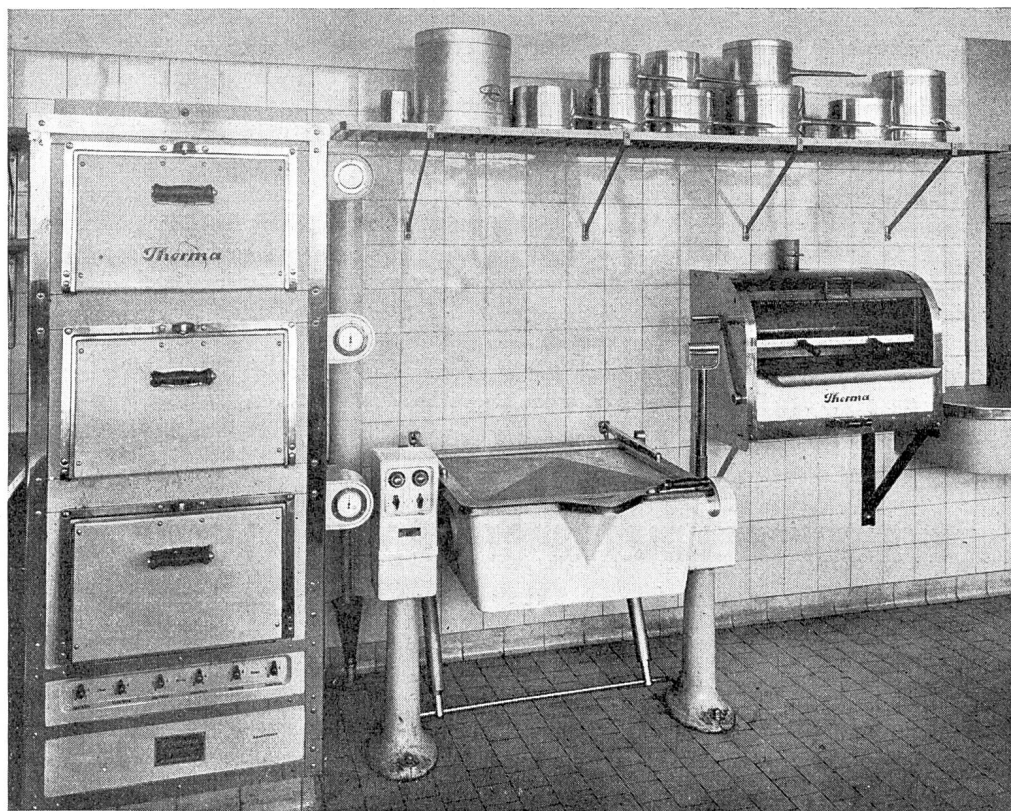
Abb. 4 Der elektrische Brat- und Backofen, die elektrische Bratpfanne und der elektrische Grill in der Küche des neuen Flugplatz-Restaurants Dübendorf
