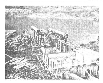
Abb. 15. Lungernseewerk, IV. Ausbau. Unteres Endstück der Leerlaufleitungen im Bau.
